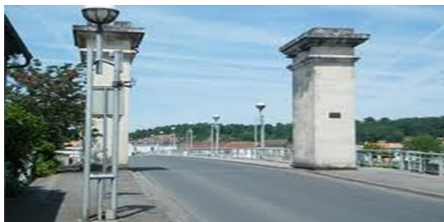
Port Ste Foy pont Montaigne
